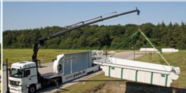
Einbau mit Betonhinterfüllung
