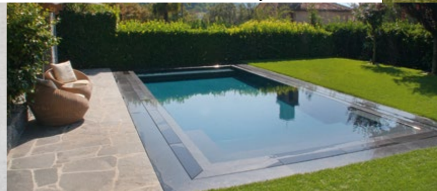
Freibad mit bauseits steinüberdeckter Überlaufrinne.
